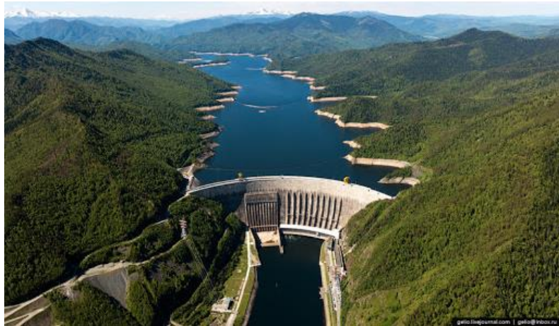
Гидроузел СШГЭС им. П.С. Непорожного
