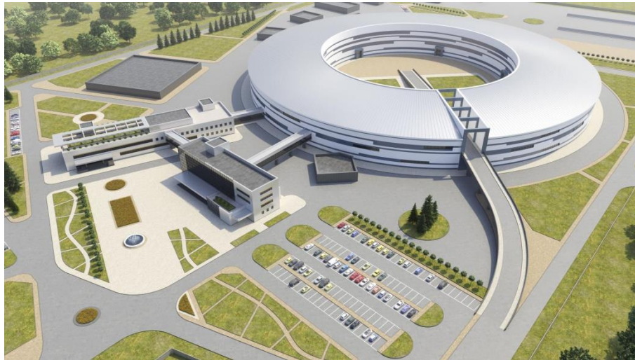
Комплекс сооружений ЦПК «СКИФ»
