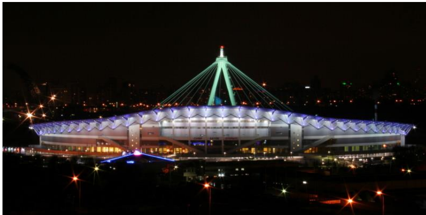
Крытый конькобежный центр «Крылатское»
